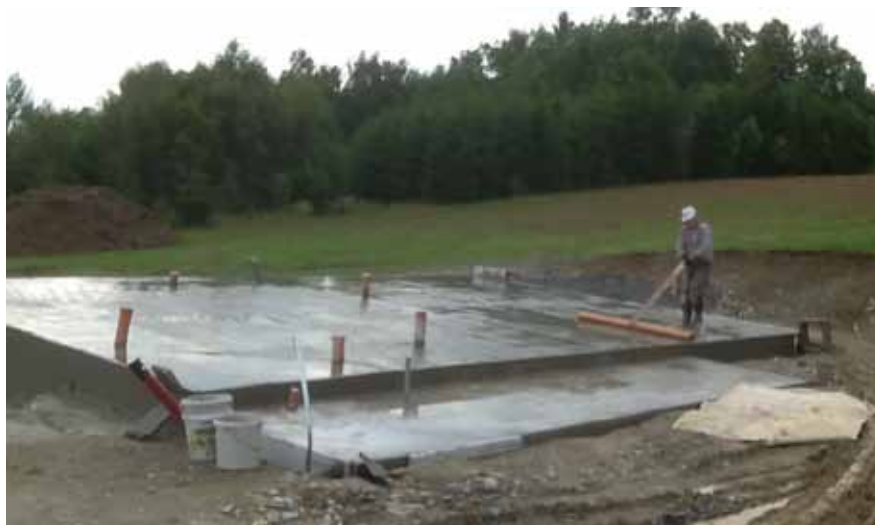
Svrchní vrstvu betonu bylo potřeba ručně srovnat a vyhladit dřevěným hřebem
